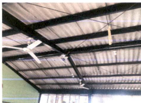
Foto 4: SUSTITUCIÓN DE LÁMINA POR LÁMINA TROQUELADA MÓDULO 2
