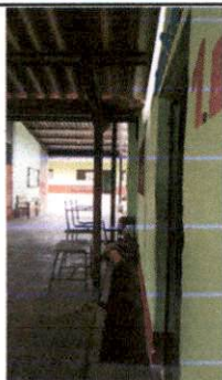
Foto 11: REPARACIÓN DE BAJADA DE AGUA PLUVIAL
