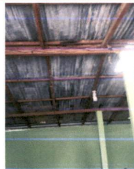
Foto 2: SUSTITUCIÓN DE ESTRUCTURA DE MADERA POR METAL MÓDULO 1
