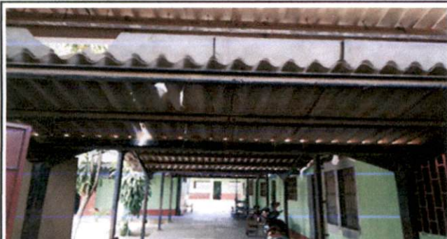
Foto 5: MANTENIMIENTO DE ESTRUCTURA DE SOPORTE DE METAL MÓDULO 3
