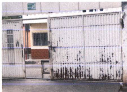
Foto 7: MANTENIMIENTO DE PORTÓN DE METAL
