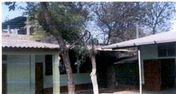
Foto 1: SUSTITUCIÓN DE ESTRUCTURA DE MADERA POR METAL MÓDULO 1
