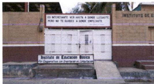
Foto 8: MANTENIMIENTO DE PORTÓN DE METAL
