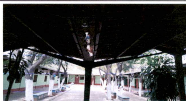
Foto 6: MANTENIMIENTO DE ESTRUCTURA DE SOPORTE DE METAL MÓDULO 3
