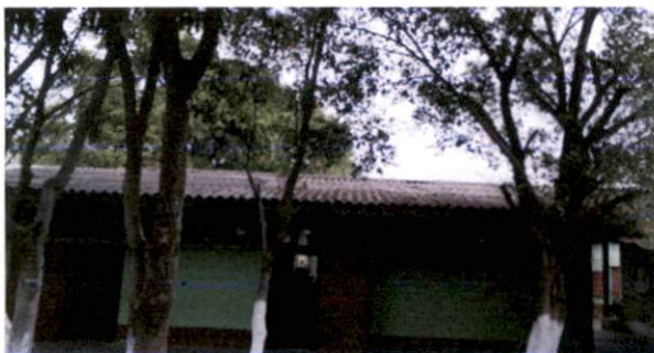
Foto 3: SUSTITUCIÓN DE LÁMINA POR LÁMINA TROQUELADA MÓDULO 2
