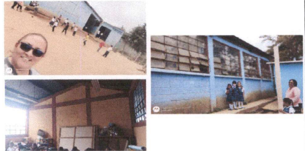
Foto 2: PINTURA EN MUROS EXTERIORES E INTERIORES
