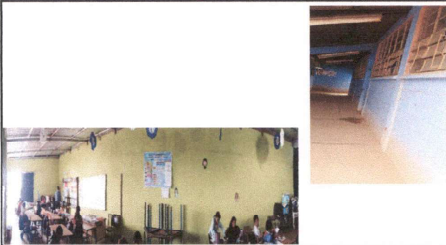
Foto 3: PINTURA EN MUROS EXTERIORES E INTERIORES
