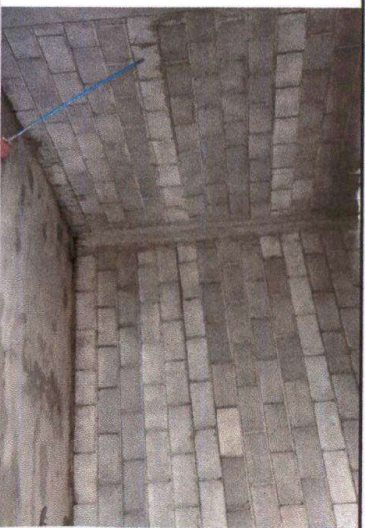
Foto 2: Reparación de muro perimetral
