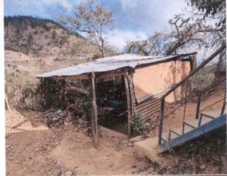
Foto 2: reparación de aula
