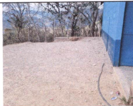
Foto 5 : Losa de patio
