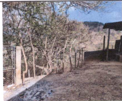
Foto 6: Cerco o muro perimetral
