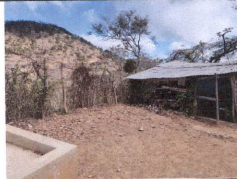
Foto 4: losa de patio
