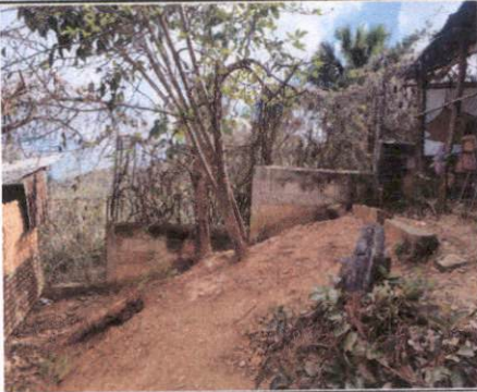
Foto 3: Reparación de muro de contención
