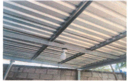
Foto 2: Sustitucion de lamina y estructura metalica
