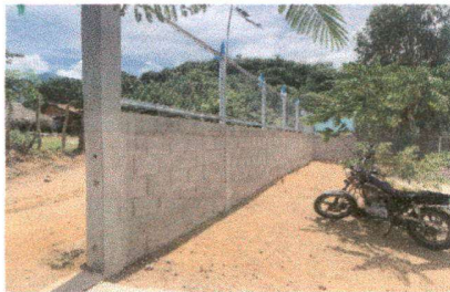
Foto 3: Mantenimiento de muro perimetral
