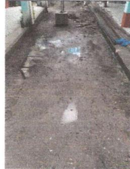
Foto 8: SUSTITUCION DE LOSA DE CONCRETO
