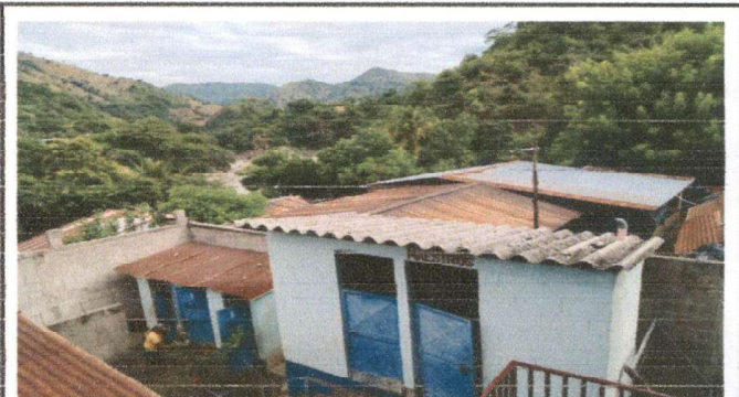
Foto 4: techado del area de sanitarios existentes
