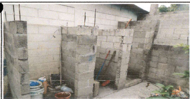
Foto 5: repello de paredes area de sanitarios
