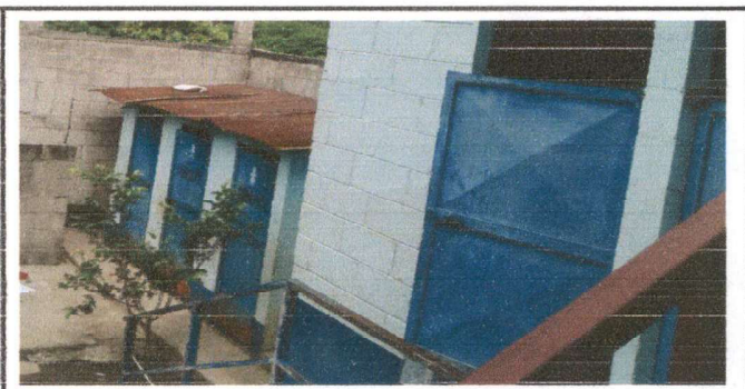
Foto 6: reparacion de puertas
