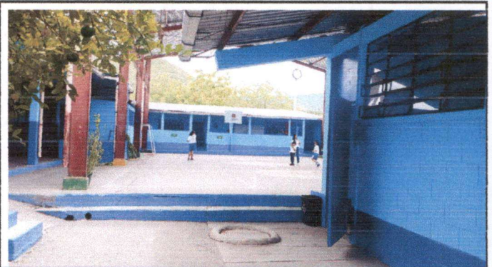
Foto 2: Pintura de interiores y Exteriores
