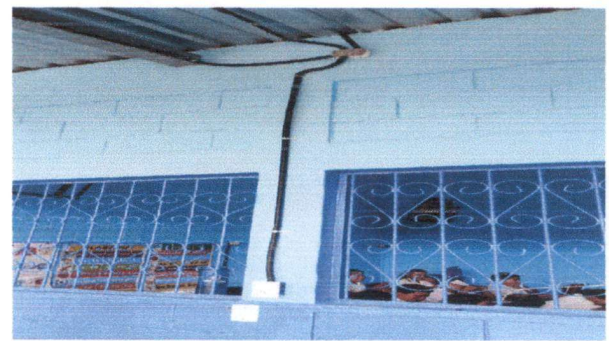
Foto 4: Reparación Sistema Eléctrico
