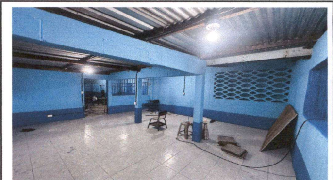
Foto 4: Cambio del Sistema Eléctrico
