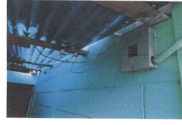
Foto 4: Cambio del sistema eléctrico del Establecimiento
