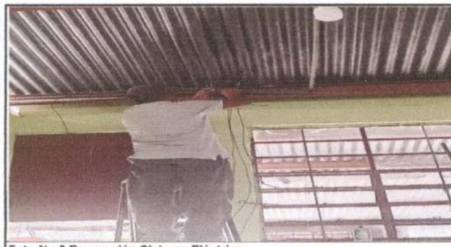
Foto No.5 Reparación Sistema Eléctrico
