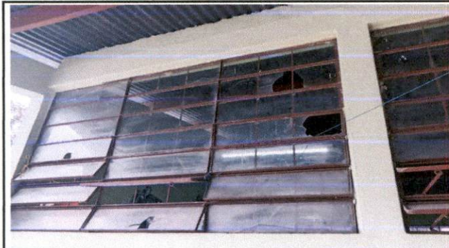
Foto No.3 Sustitución de ventanas
