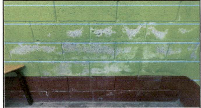
Foto No. 4 Pintura de interiores y exteriores
