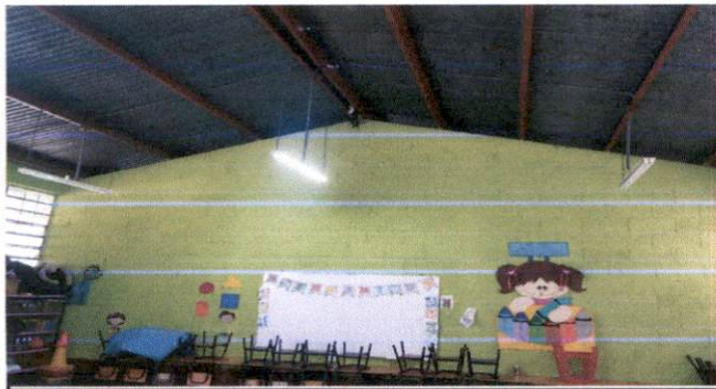
Foto No.5 Reparación Sistema Eléctrico
