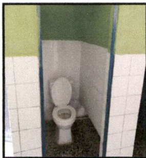
Foto 5: SUSTITUCIÓN DE BAÑOS.
