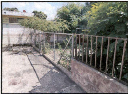
Foto 3: CONSTRUCCIÓN DEL MURO PERIMETRAL CON MALLA.
