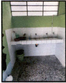
Foto 1: REMODELACIÓN DE LAVAMANOS Y PINTURA.
