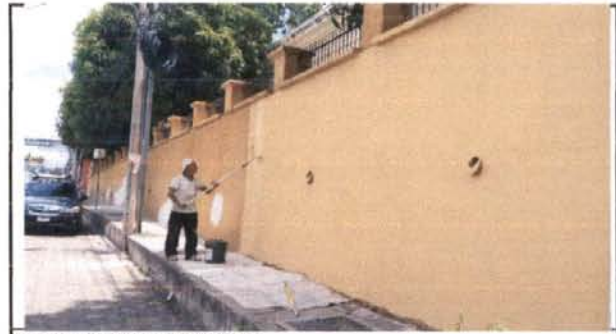
Foto 12: PINTURA DE MUROS
