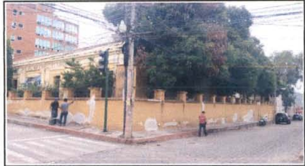
Foto 8: TRATAMIENTO Y REPELLO DE MUROS
