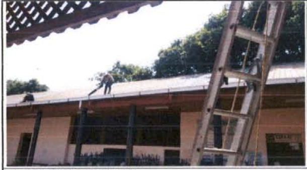
Foto 4: LIMPIEZA DE CANALES
