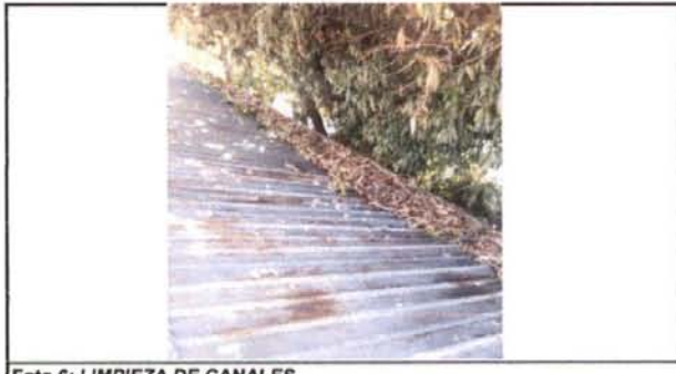
Foto 6: LIMPIEZA DE CANALES
