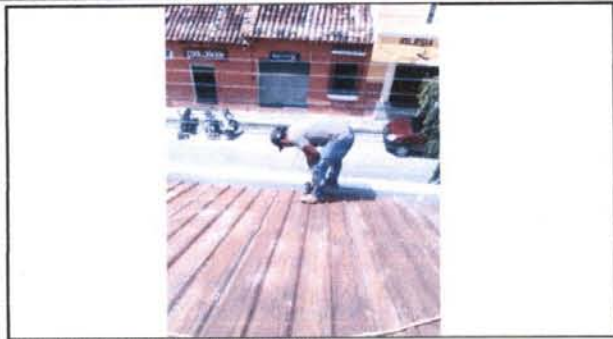
Foto 1: REATORNILLADO EN TECHOS
