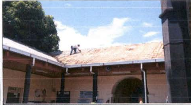
Foto 3: REATORNILLADO EN TECHOS
