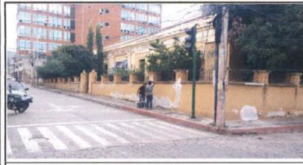
Foto 11: TRATAMIENTO Y REPELLO DE MUROS
