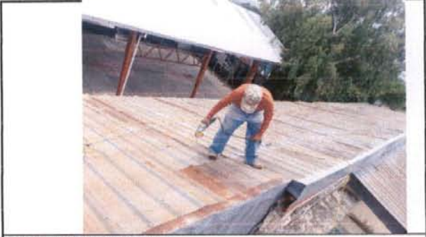
Foto 2: LIJADO DE TECHOS
