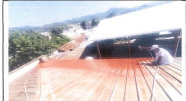
Foto 10: PINTURA DE TECHOS
