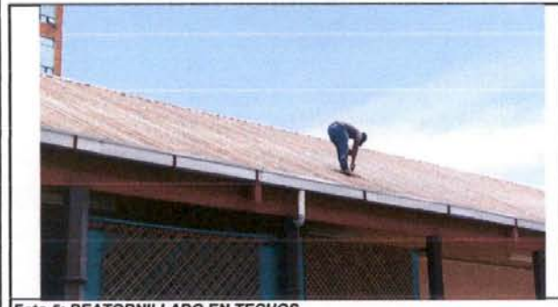
Foto 5: REATORNILLADO EN TECHOS
