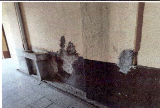
Foto 5: TRATAMIENTO Y PINTURA EN MUROS INTERIORES
