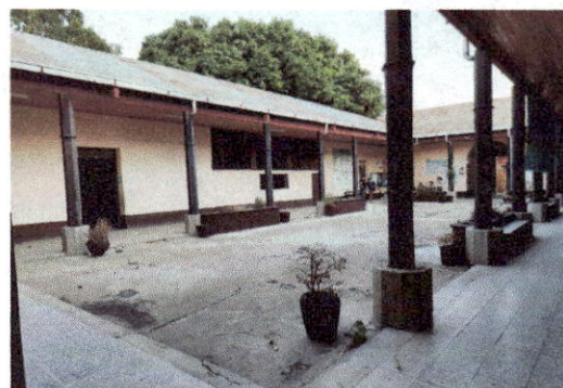
Foto 2: TRATAMIENTO Y PINTURA EN TECHO DE LAMINA EXTERIORES
