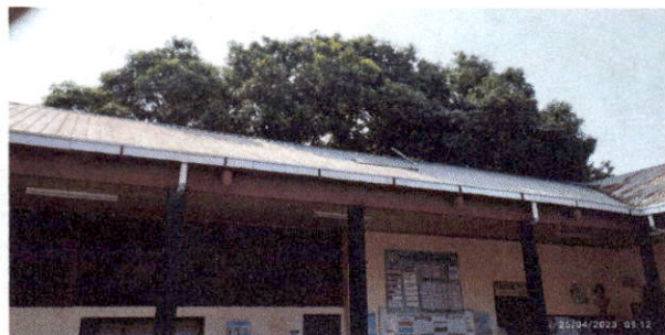
Foto1: . Limpieza de canales y colocación de malla
