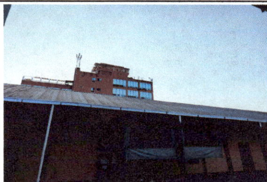
Foto 3: TRATAMIENTO Y PINTURA EN TECHO DE LAMINA EXTERIORES
