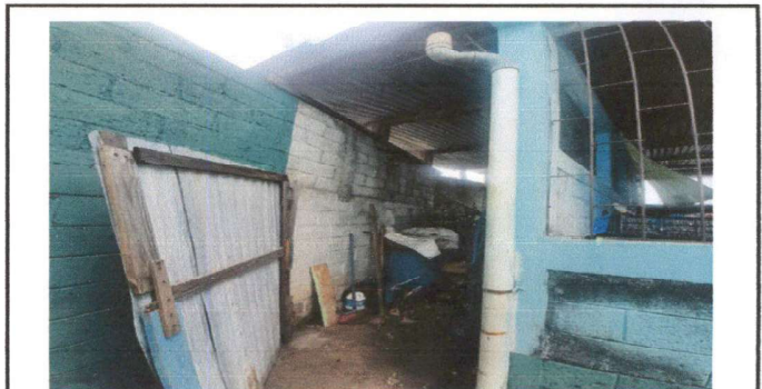
Foto 6: Instalación de estructura de metal para base de depósito de agua
