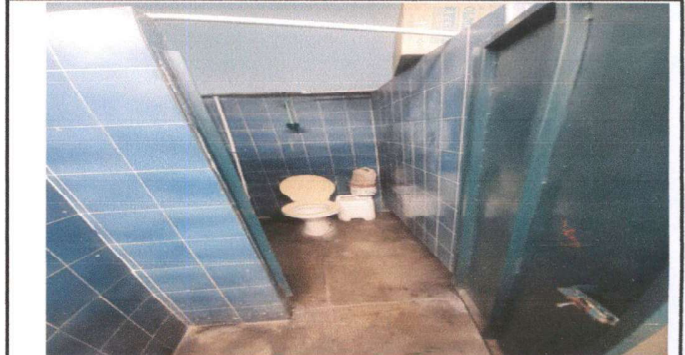
Foto 2: Sustitución de inodoro en mal estado
