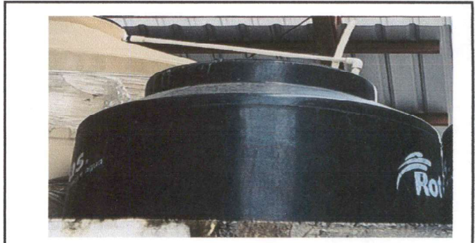
Foto 4: Sustitución de deposito de Agua
