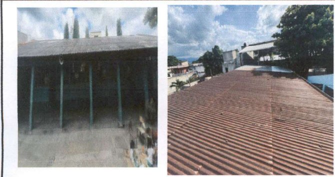
Foto 1: Sustitución de lamina de duralita por lámina troquelada
