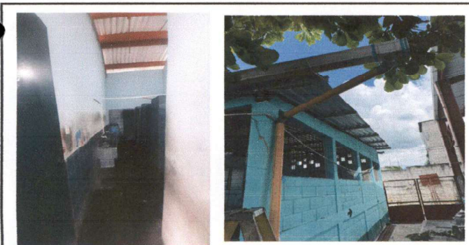
Foto 5: Sustitución de tubería pluvial
