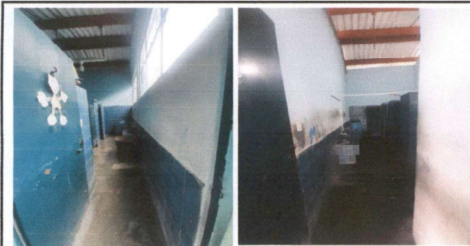
Foto 3: Sustitución de grifos en baños de niñas y niños
