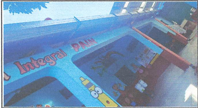
Foto 2: CANALES, BAJADAS DE AGUA Y ELEVACIÓN DEL COJINETE
