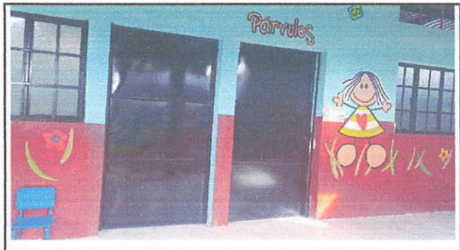
Foto 4: CAMBIO DE PUERTAS Y VENTANAS
