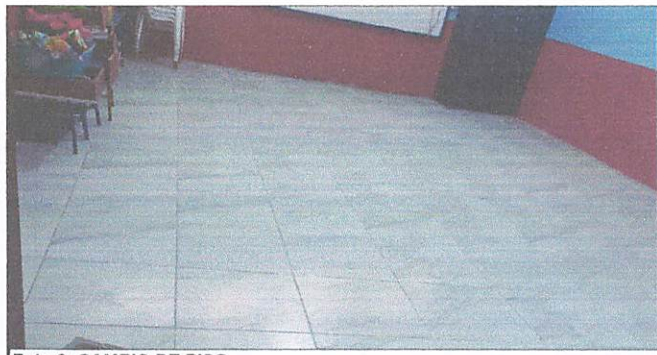
Foto 6: CAMBIO DE PISO
