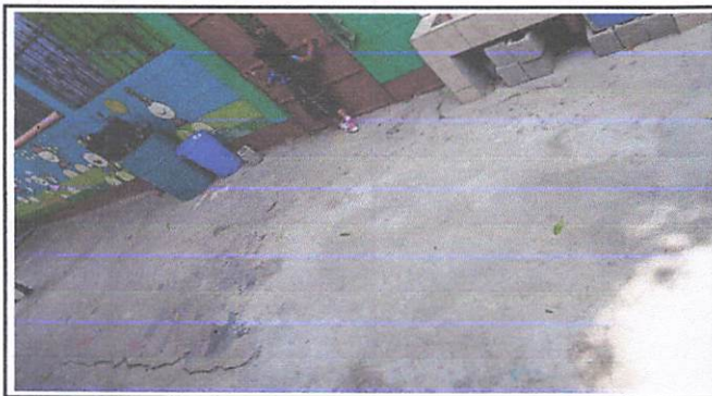
Foto 3: FUNDICIÓN DE LOSA DEL PATIO
