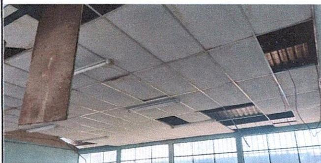
Foto 11: Retirada de cielo falso
