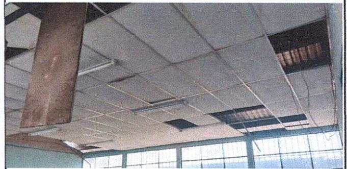
Foto 12: Cambio de acometida eléctrica, quitado de cableado, instalación de nuevo cableado e instalación de 18 unidades de luz.
