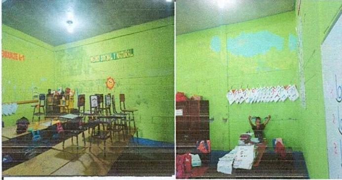
Foto1: PINTURA EN MUROS INTERIOR (IMPERMEABILIZANTE) PARA EVITAR QUE LA HUMEDAD SE FILTRE EN 8 AULAS.
