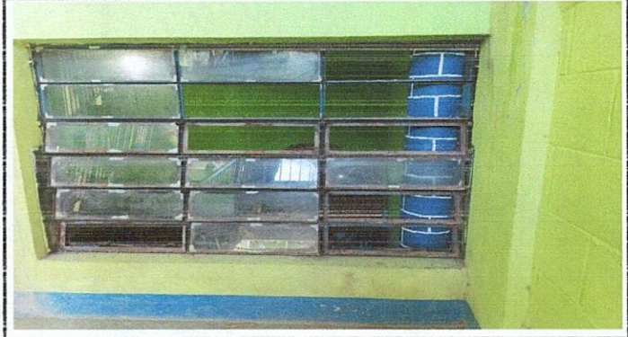
Foto 2: CAMBIO DE 100 VIDRIOS
