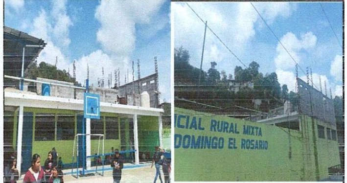
Foto 2: ESTRUCTURA DE TECHO, CONSTRUCCION EN POCESO DE 2 AULAS Y UNA BODEGA
