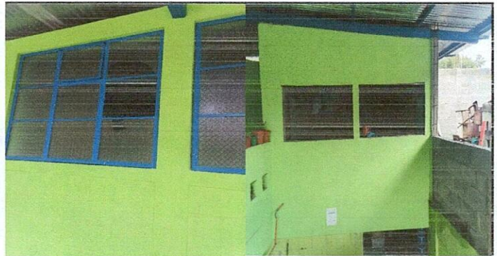
Foto 6: CAMBIO DE 100 VIDRIOS
