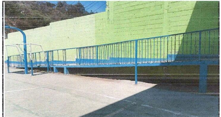
Foto 4: MANTENIMIENTO Y MEJORAMIENTO DE BARANDA
