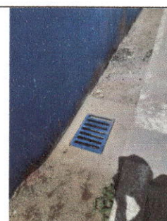
Foto 1 Cajas de captación con base de ladrillo y rejillas.
