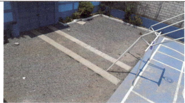
Foto 2 Fundición de loza en patio veinticinco metros cuadrados (Loza de patio)
