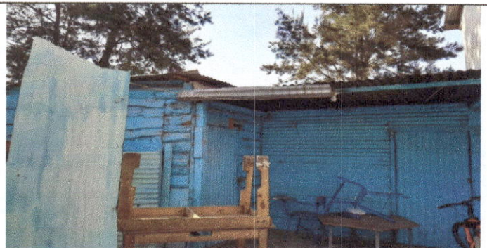
Foto 2 Sustitución de lamina de bodega de 14 pies (Cubierta de laminas)
