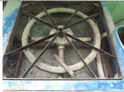
Foto 2 Sustitución de cilindro para gas (Reparación o sustitución de area de cocina)
