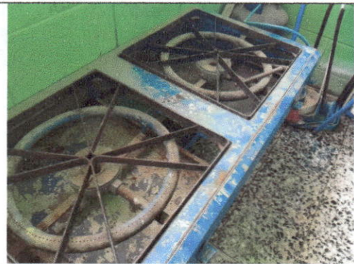
Foto 2 Sustitución de estufa industrial de tres hornillas (Reparación o sustitución de área de cocina)
