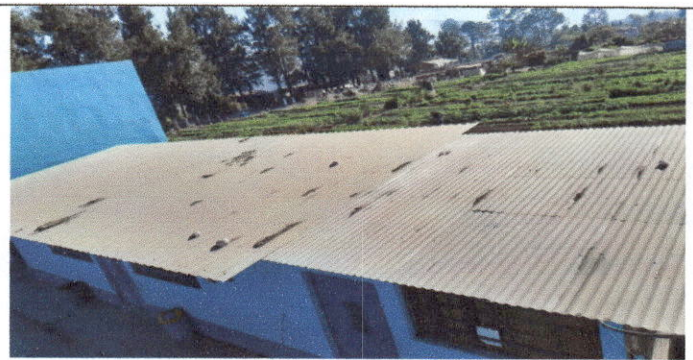
Foto 2 Pintura de techo exterior (Cubierta de laminas)
