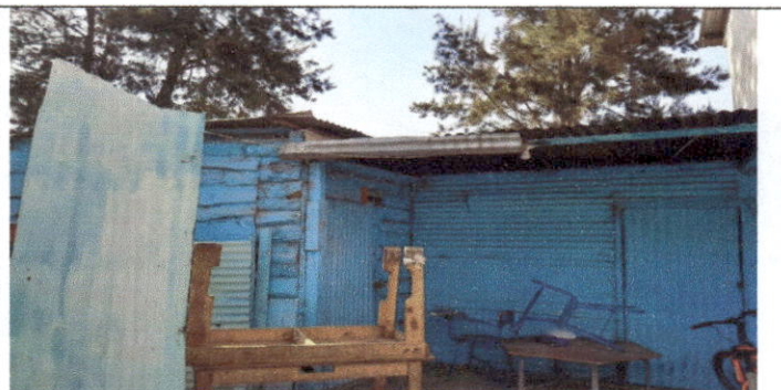
Foto 2 Sustitución de costaneras de 4x2 pulgadas para columnas (Estructura de techo)
