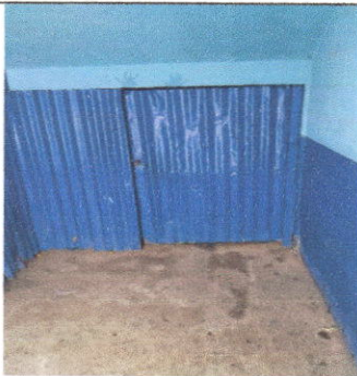
Foto 1 Colocación puertas de acceso (Puertas)
