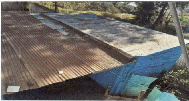
Foto1 Sustitución de costaneras de 4x2 pulgadas para columnas (Estructura de techo)
