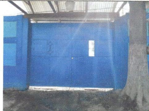
Foto 2 Sustitución de un portón principal de 2.96x2.30 mts. (Mantenimiento a portones)
