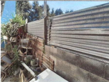
Foto 1 Culminación de muro perimetral con tubos de hierro galvanizado (Cercos o muros perimetrales)
