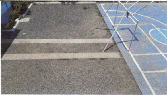
Foto 1 Fundición de loza en patio veinticinco metros cuadrados (Loza de patio)
