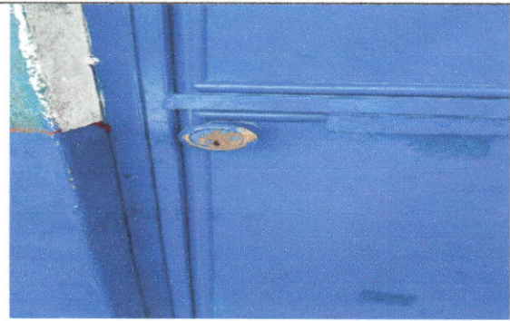
Foto 2 Cambio de 3 chapas (Puertas)
