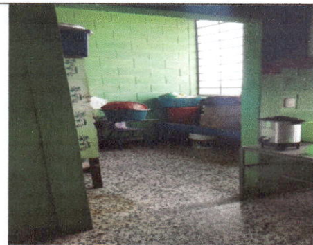
Foto 2 Colocación puertas de acceso (Puertas)
