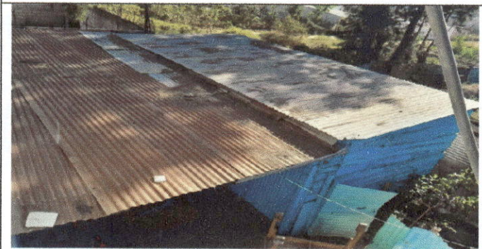
Foto 1 Sustitución de lamina de bodega de 14 pies (Cubierta de laminas)
