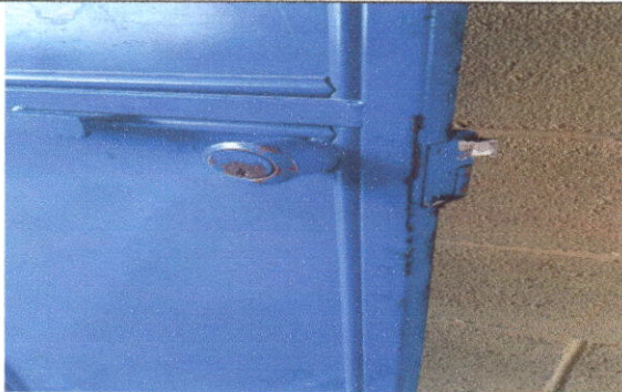
Foto 1 Cambio de 3 chapas (Puertas)
