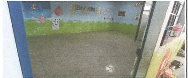
colocacion de piso en salones
