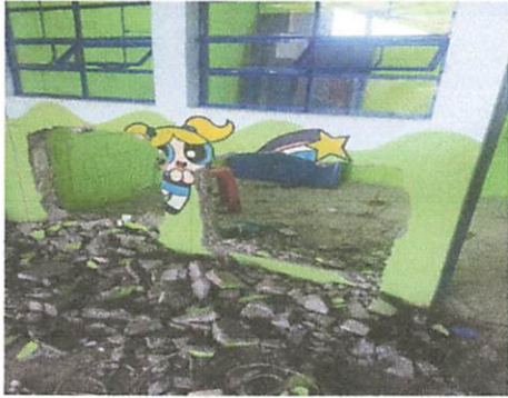
demolicion de muro de cocina
