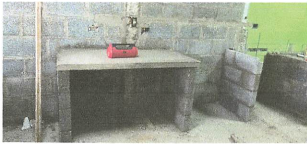
elaboracion de gabinetes
