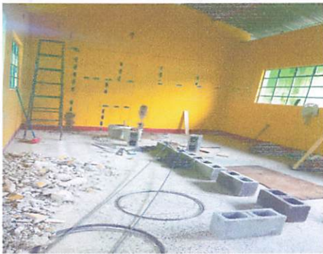
Foto 3: instalación gabinetes de concreto forrado de azulejo para traslado de cocina.
