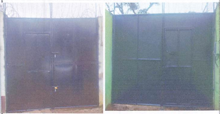
Foto 1: mantenimiento de portón principal
