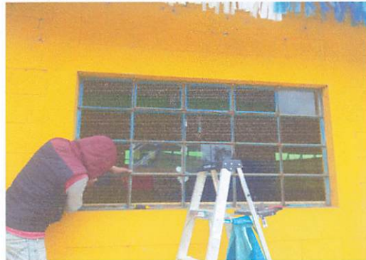
Foto 2: colocar vidrios en las ventanas y en la ventana de puerta, para cocina.
