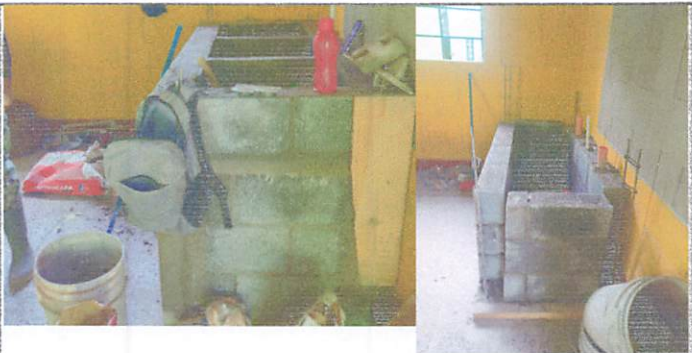
Foto 5: instalación de un lavatrastos y reparación instalación eléctrica.
