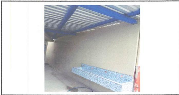
Foto 5: Lavamanos terminado con 4 chorros, con su respectivo tubo de drenaje y agua potable.
