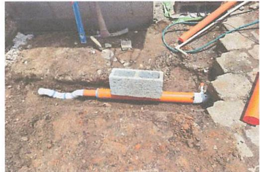
Foto 4: colocación de tuberías de drenajes respectivos para el área estipulada.
