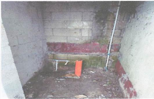
Foto 3: distribución de tuberías de drenaje y agua potable para los sanitarios.
