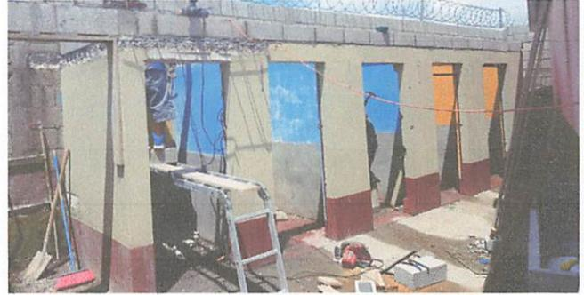
Foto 2: levantado de pared, colocación de piso y azulejo.
