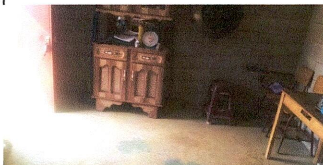
Foto 2: en cocina el piso es muy rustico y ha habido accidentes.
