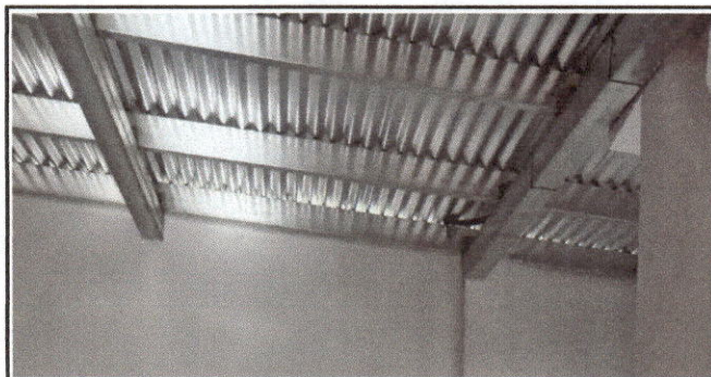
Foto 5: ESTRUCTURA METÁLICA NUEVA.
