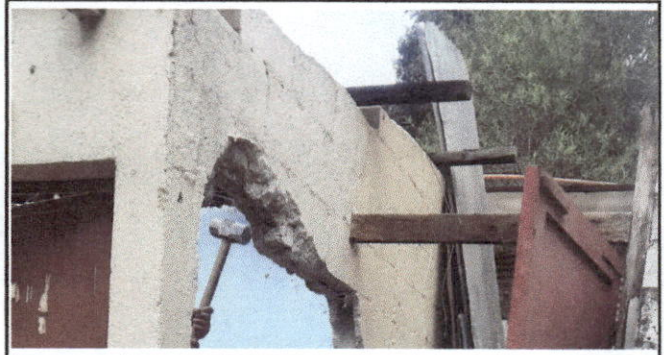
Foto 2: DESMONTAJE DE TECHO
