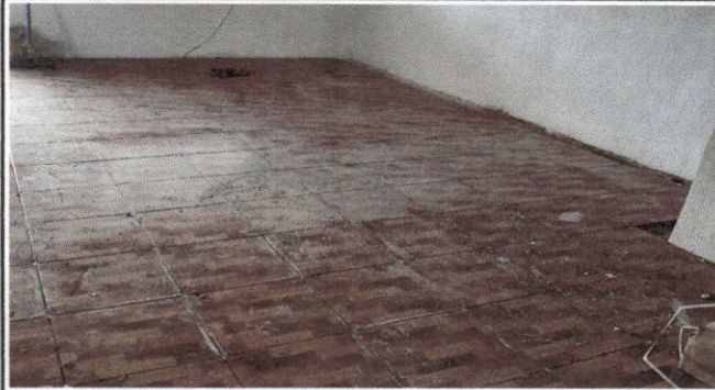
Foto 1: TRABAJOS DE COLOCACIÓN DE PISO.
