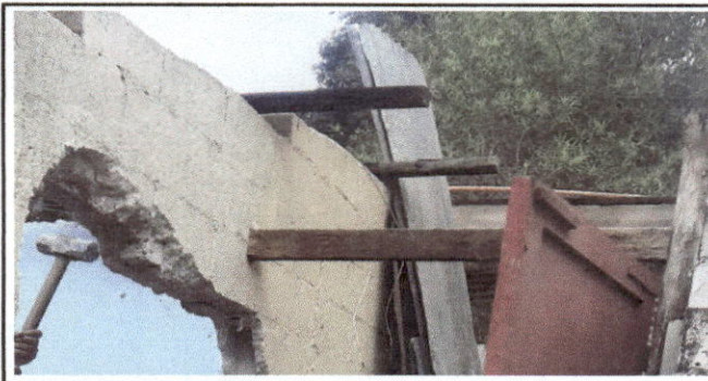
Foto 5: DESMONTAJE DE ESTRUCTURAS DE MADERA.
