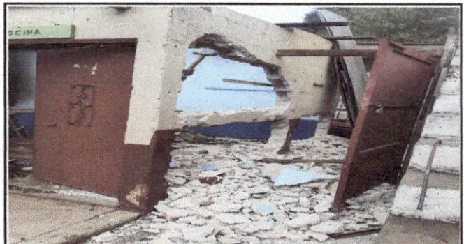
Foto 6: DEMOLICIÓN Y REMODELACIÓN DE LA COCINA.
