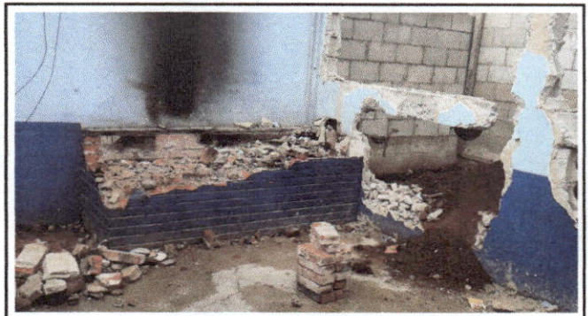
Foto 4: DEMOLICIÓN DE LA ESTUFA DE LEÑA.
