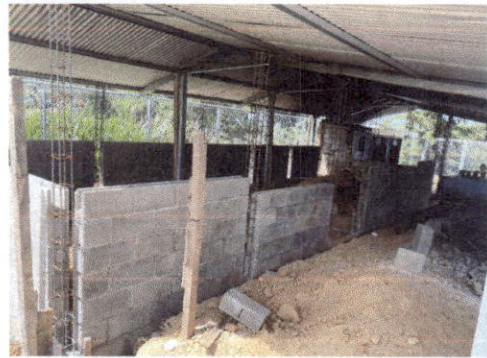
Foto 2: la pared que será de soporte para la cocina esta en proceso
