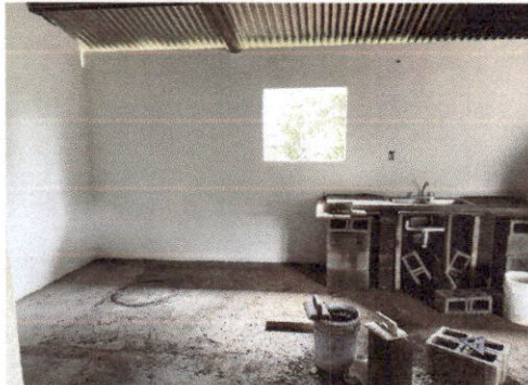
Foto 4: el cernido y repello de las paredes además del lavatrastos
