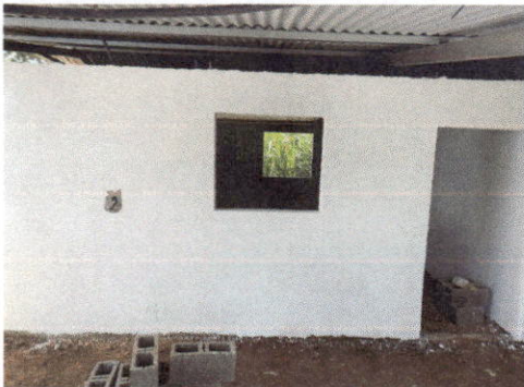
Foto 3: se iniciaba con el cernido y repello de paredes y a palmasar la tierra para la losa.
