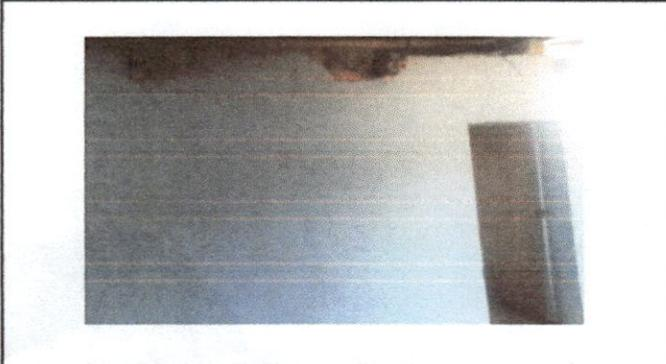
Foto 3: cocina en malas condiciones, empieza a caer se por partes por ser de Adobe.
