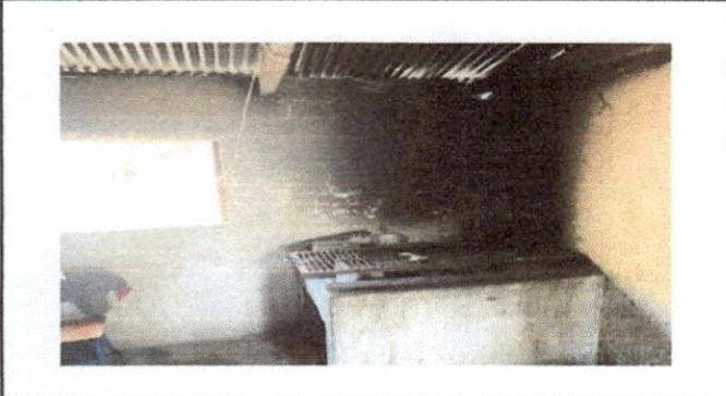
Foto1: cocina de leña en mal estado con sus implementos oxidados
