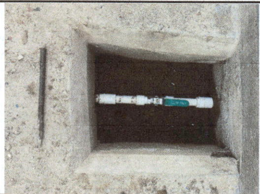
Foto 10: llaves de paso de agua remozadas
