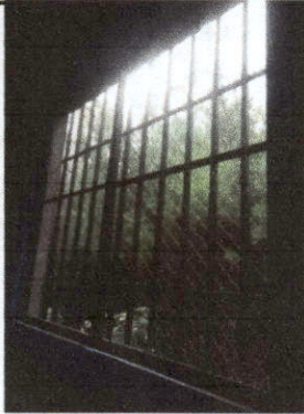
Foto 7: ventana y balcón en baños.
