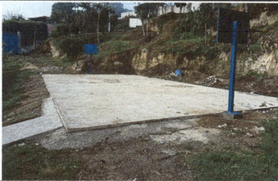
foto 11: plancha de concreto en patio trasero
