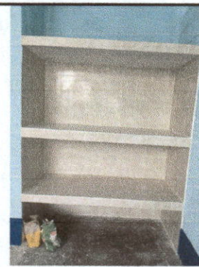
foto 4: mueble fijo de concreto en cocina
