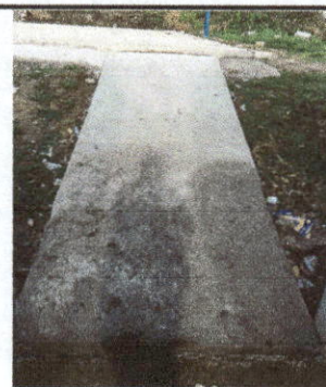
foto 6: rampa de concreto en patio trasero
