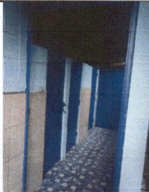
Foto 9: piso, azulejo y pintura en baños interiores
