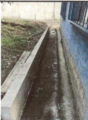
foto 3: pared en patio trasero
