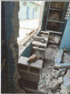
foto 9: elaboración de ventana y mueble de concreto en cocina
