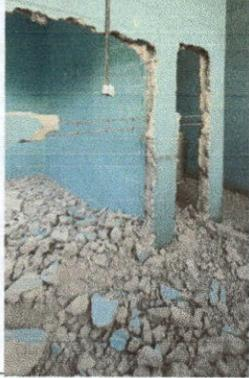
foto 7: demolición de pared por ampleación de cocina
