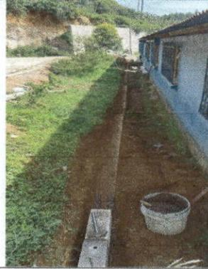
foto 8: levantado de dos hiladas de block en patio trasero
