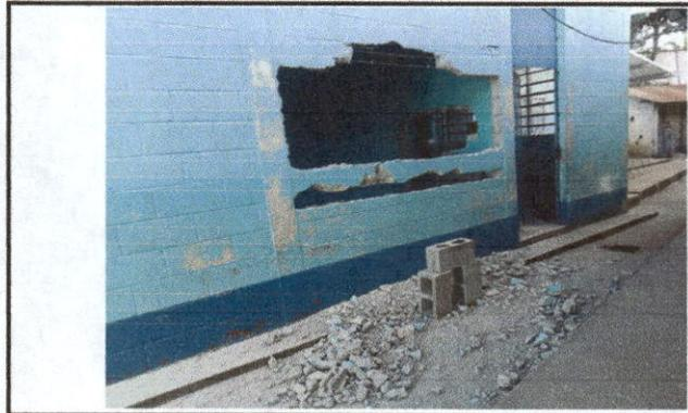
Foto 2: demolición de pared para ventana en cocina.
