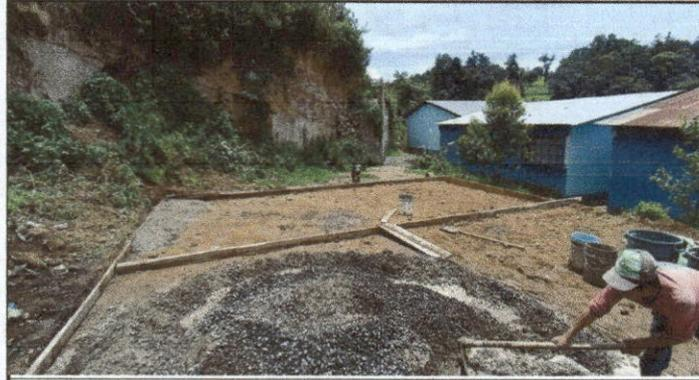
Foto 1: Fundición de plancha de cemento en patio trasero.
