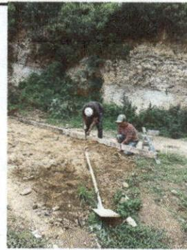
foto 12: fundición de rampa de concreto hacia patio trasero
