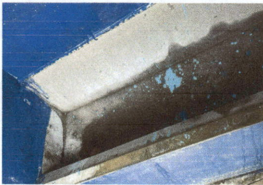
Foto 3: Migratorios de los baños exteriores.
