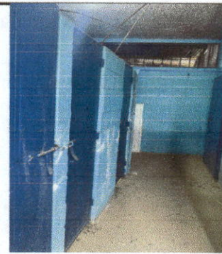
Foto 6: Interior de los baños interiores.
