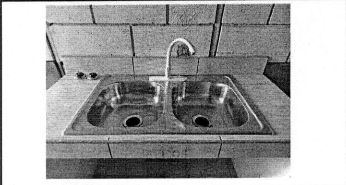
Foto 2: LAVAMANOS FUNDIDO E INSTALADO
