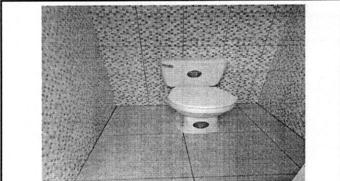
Foto 4: COLOCACION DE PISO EN BODEGA PARA BASURA, EN SANITARIOS Y SUTTUCION DE SANITARIOS Y AZULEJO.
