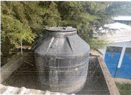
Foto 5: Tinaco en mal estado ubicado en lado este
