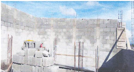
Foto 5: levantado de pared segundo nivel
