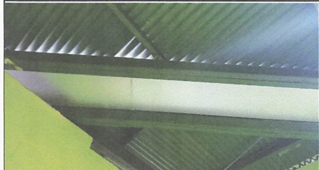
Foto 4: colocados los canales
