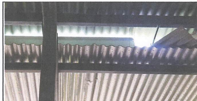
Foto 6: cambiados canales del patio
