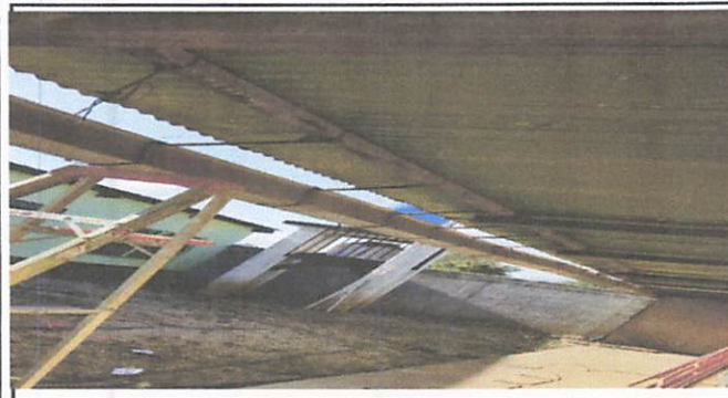
Foto 3: componiendo techado y canales
