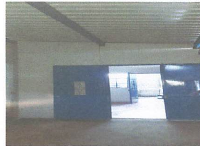
Foto 4: techado en bodega
