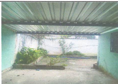
Foto 5: techo para bodega y direccion
