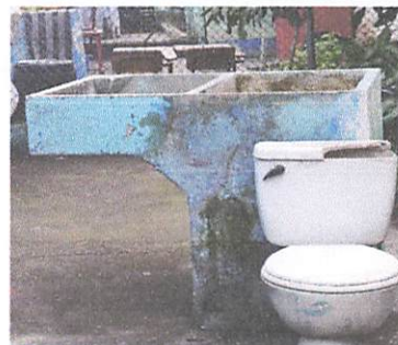
Foto 6: REPARACION DE DRENAJES Y RED DE AGUA POTABLE.
