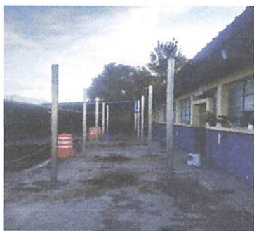
Foto 3: ESTRUCTURA DE TECHO, CUBIERTA DE LAMINA, CANALES Y BAJADA DE AGUA PLUVIAL.
