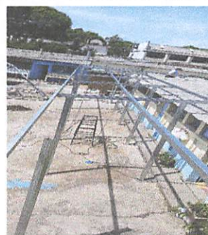
Foto 2: ESTRUCTURA DE TECHO, CUBIERTA DE LAMINA, CANALES Y BAJADAS DE AGUA PLUVIAL.
