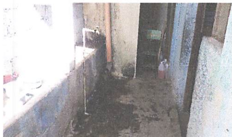
Foto 5: REPARACION DE DRENAJES Y RED DE AGUA POTABLE
