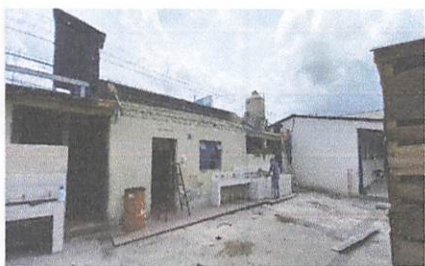
Foto 1: ESTRUCTURA DE TECHO, CUBIERTA DE LAMINA Y BAJADAS DE AGUA PLUVIAL
