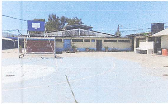
Foto 3: ESTRUCTURA DE TECHO, CUBIERTA DE LAMINA, CANALES Y BAJADA DE AGUA PLUVIAL.
