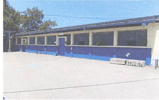
Foto 2: ESTRUCTURA DE TECHO, CUBIERTA DE LAMINA, CANALES Y BAJADAS DE AGUA PLUVIAL.
