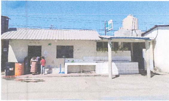
Foto1: ESTRUCTURA DE TECHO, CUBIERTA DE LAMINA Y BAJADAS DE AGUA PLUVIAL
