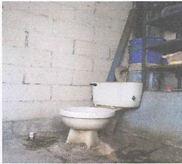
Foto 5: REPARACION DE DRENAJES Y RED DE AGUA POTABLE
