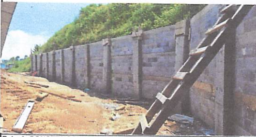
Foto 4: CONSTRUCCION DE MURO DE CONTENCIÓN
