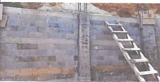
Foto 5: CONSTRUCCION DE MURO DE CONTENCIÓN
