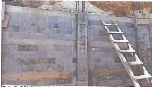
Foto 2: CONSTRUCCION DE MURO DE CONTENCIÓN
