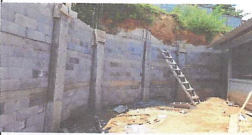
Foto 3: CONSTRUCCION DE MURO DE CONTENCIÓN
