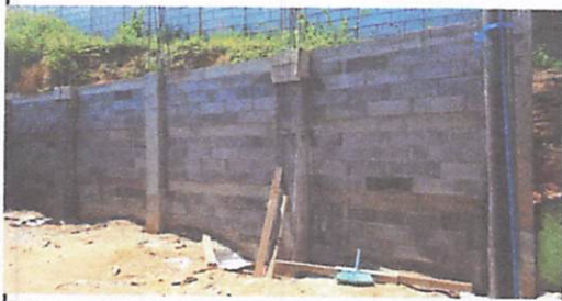
Foto 1: CONSTRUCCION DE MURO DE CONTENCIÓN
