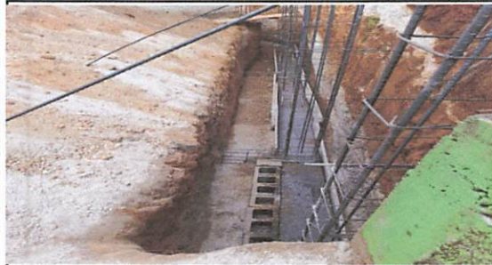
Foto 1: CONSTRUCCION DE MURO DE CONTENCIÓN
