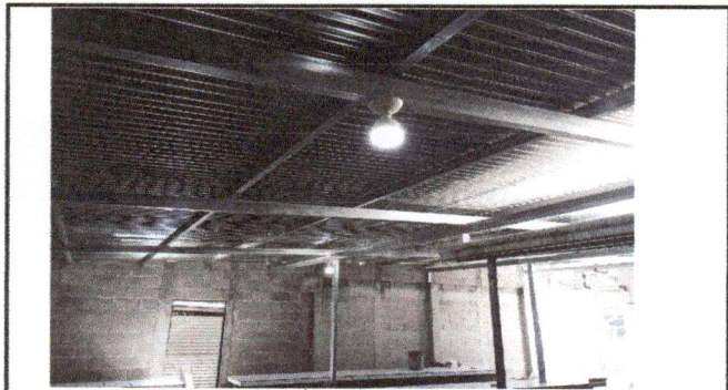
INSTALACION DE ENERGIA ELECTRICA
