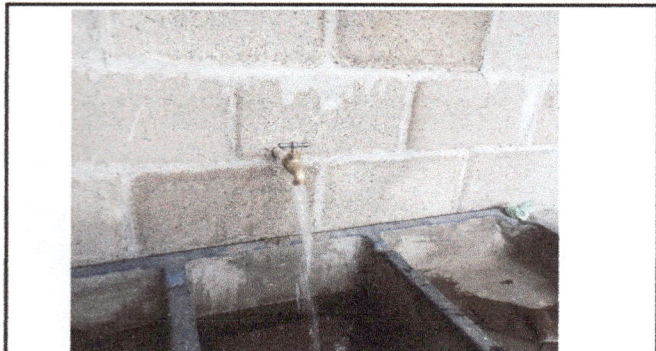
INSTALACION DE TUBERIAS PARA AGUA POTABLE
