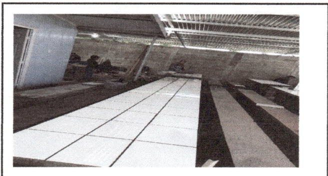
INSTALACION DE AZULEJO EN MESA
