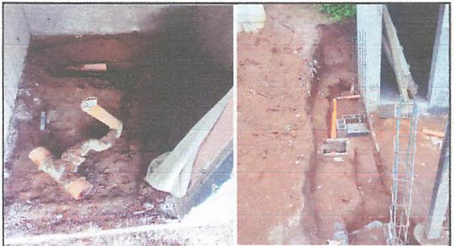
Foto 4: Cambios de tubería interna y externa
