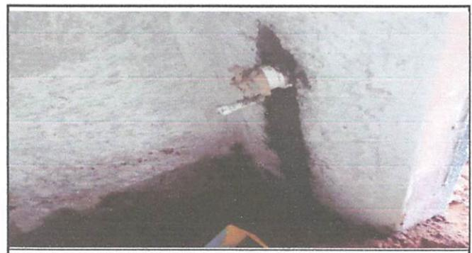
Foto 6: Tubería de lavamanos inexistente y por ende existencia de fugas de agua.
