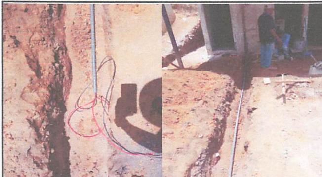
Foto 3: introducción subterránea de la energía electrica.
