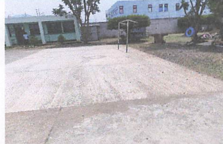
Foto 6: Cementado con desnivel, canales y bajadas
