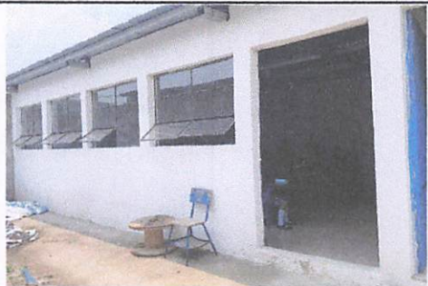
Foto 3: Repello, cernido, canales y bajada
