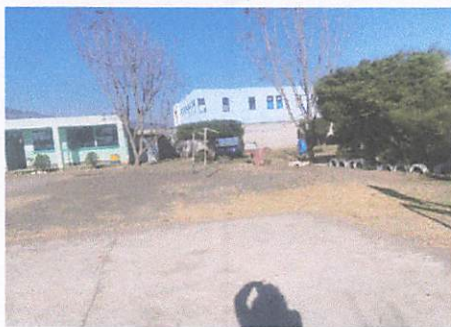
Foto 5: Cementado con desnivel
