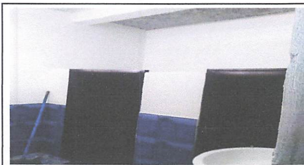
Foto 5: COLOCACIÓN DE PUERTAS EN SANITARIOS
