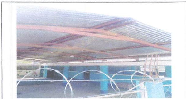
Foto 1: COLOCACIÓN DE ALAMBRE DE PUAS
