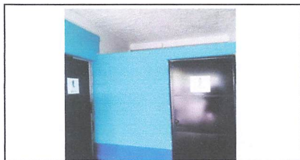
Foto 6: COLOCACION DE PUERTAS EN SANITARIOS
