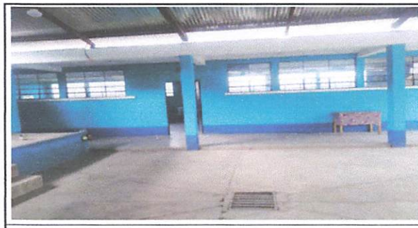
Foto 6: PINTADA DEL LADO DERECHO DEL EDIFICIO
