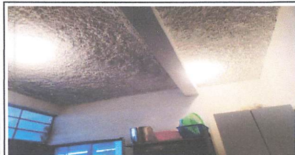
Foto 5: ENERGIA ELÉCTRICA EN COCINA NUEVA
