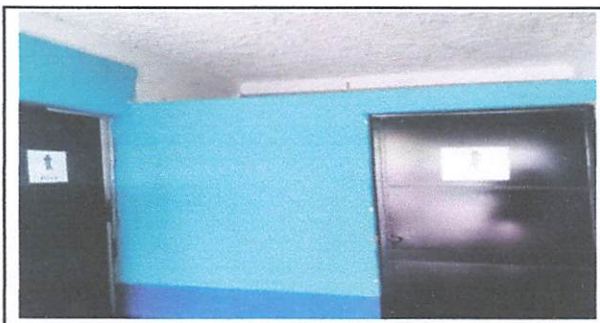
Foto 6: VISTA ENTRADA DE SANITARIOS
