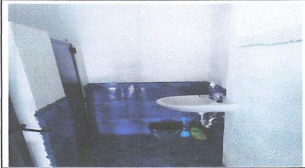
Foto 1: REPELLO Y CERNIDO EN SANITARIOS
