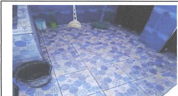
Foto 4 COLOCACIÓN DE CERAMICO EN SANITARIOS
