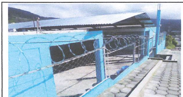
Foto 6: LADO FRONTAL DEL TECHADO
