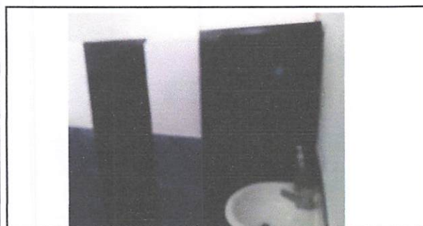
Foto 5: COLOCACIÓN PUERTAS INTERNAS EN SANITARIOS
