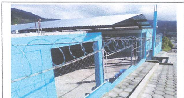
Foto 2 AREA PERIMETRAL FRONTAL ALAMBRE PUA
