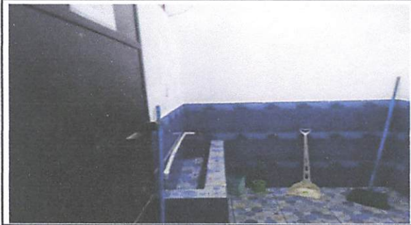
Foto 2 COLOCACIÓN DE AZULEJOS EN SANITARIOS
